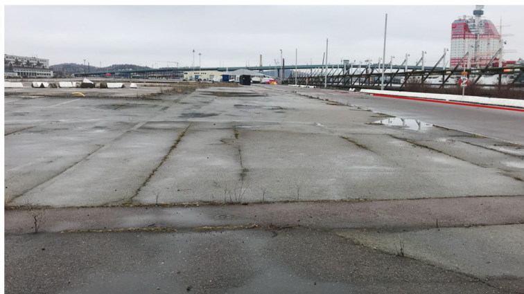
Figur 12 Asfalterad grundläggning och källarbjälklag.
